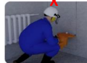
RAPORTTI 32017 Timanttsahaaja kuoli rakennustyömaalla
