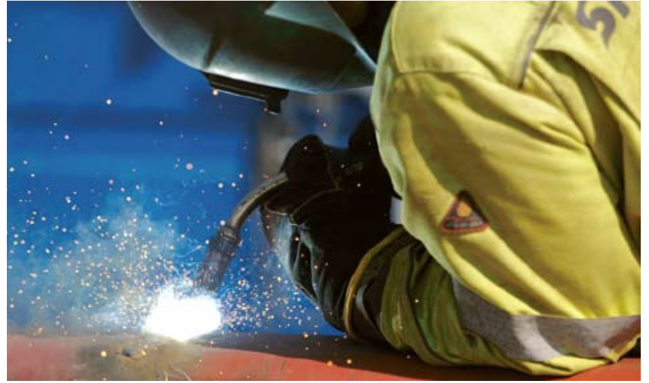
Kuva: Skanska / Risto Antikainen
