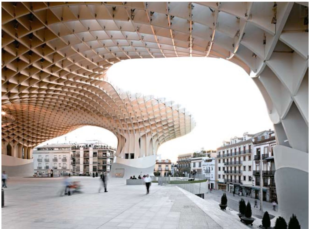
Metropol Parasol on Sevillan kaupungin uusi keulakuvaprojekti, joka avattiin yleisölle viime vuonna Espanjassa. Se on maailman suurimpia puurakentamisprojekteja, ja se koostuu 3 400 yksittäisestä puuelementistä. Maamerkin puuelementit toimitettiin Suomesta. (valokuva: Metsä Group)
